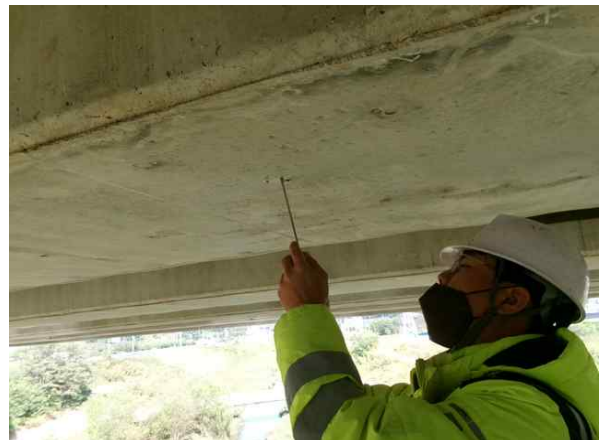
탄산화깊이 측정 현황
