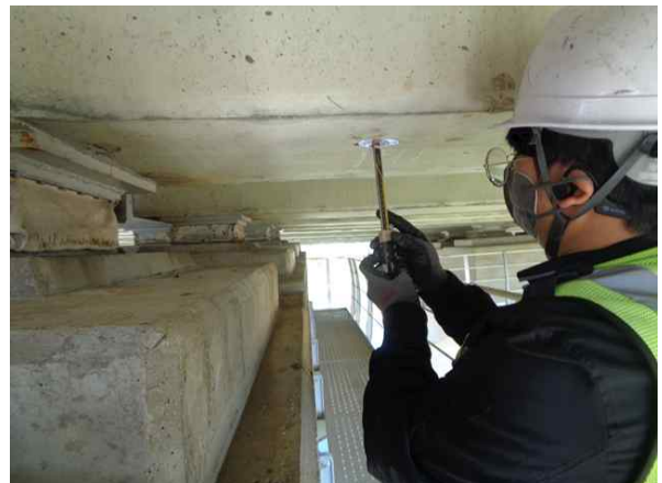
탄산화깊이 측정 현황
