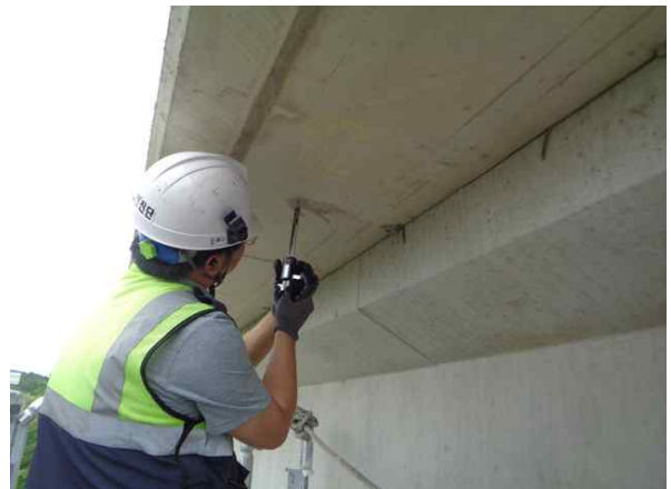
탄산화깊이 측정 현황
