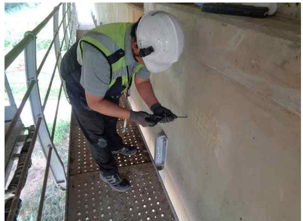
탄산화깊이 측정 현황
