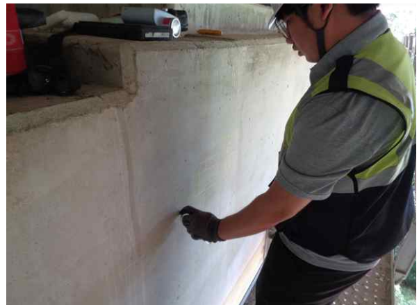
탄산화깊이 측정 현황
